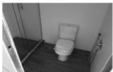
Banheiro Bloco C
