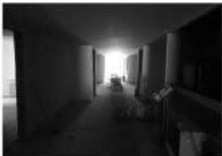
Circulação subsolo Bloco D
