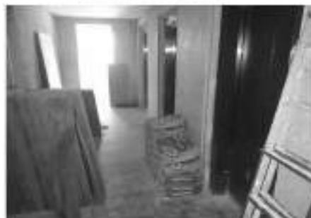
Fronte elevadores subsolo Bloco D
