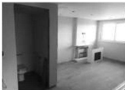
Apartamento Bloco C
